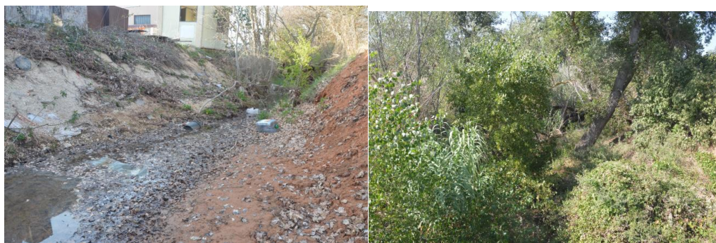
Fossé du Devens pollué et/ou obstrué (juste avant le Pont RD 900) par la végétation sur le secteur d'étude
